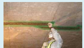
ひび割れ充填
