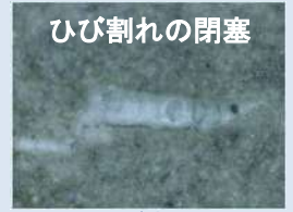
(2) ひび割れ閉塞
