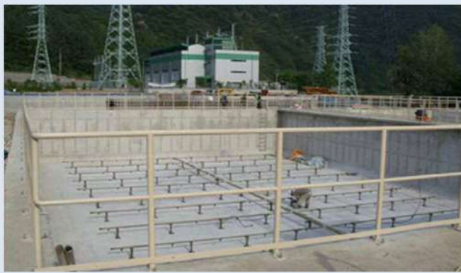
廃水処理施設
